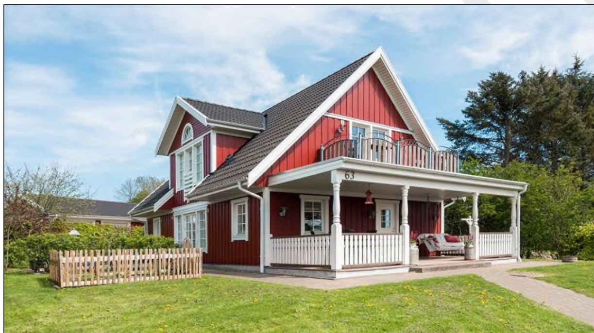
Foto, der viser den pågældende ca. 9 m 2 store altan / hævede terrasse, som er etableret oven på et overdækket areal over en anden terrasse, som der blev givet landzonetilladelse til i 2008.
